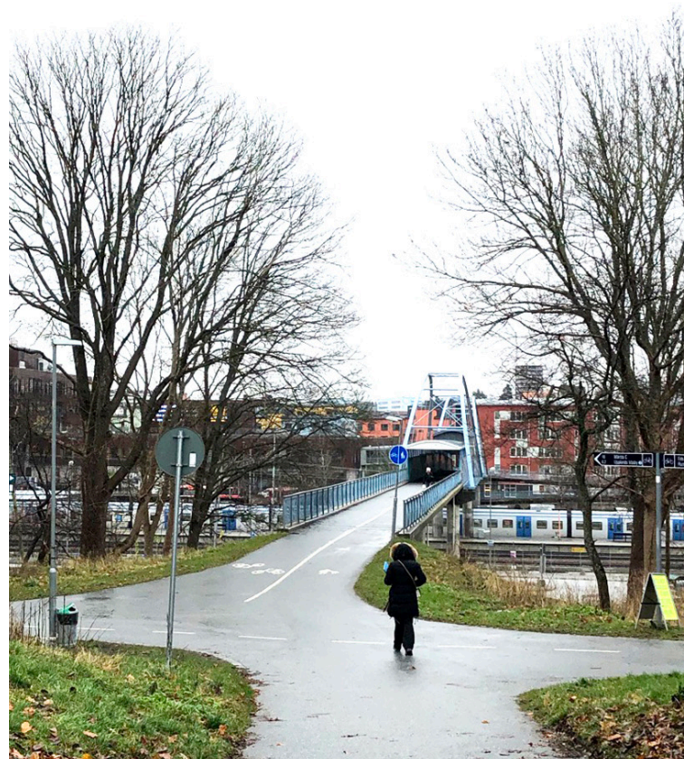
Gång- och cykelbron över järnvägen förbinder planområdets västra delar med centrumområdet i öster.
