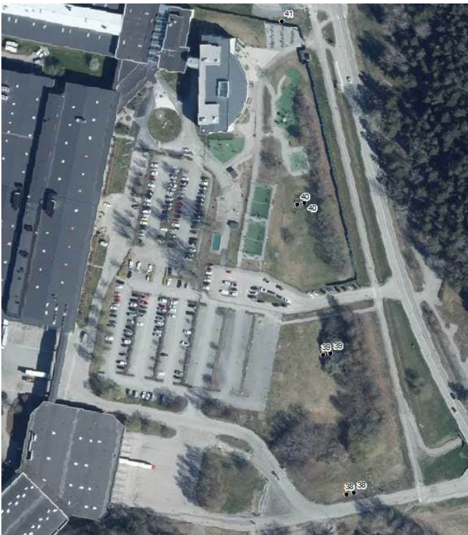
Figur 10. Lågen för ledningsstolpar som rivits och sanerats, här har även skolgården byggts ut på Älvsunda 7:9 (bild från Upplands Väsby kommun).
