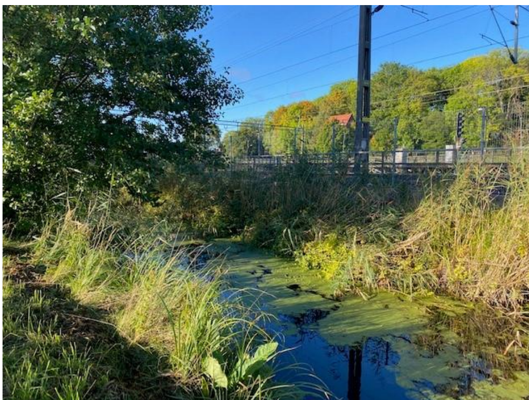
Figur 4 visar Väsbyån och stödmur mot bangården på andra sidan.
