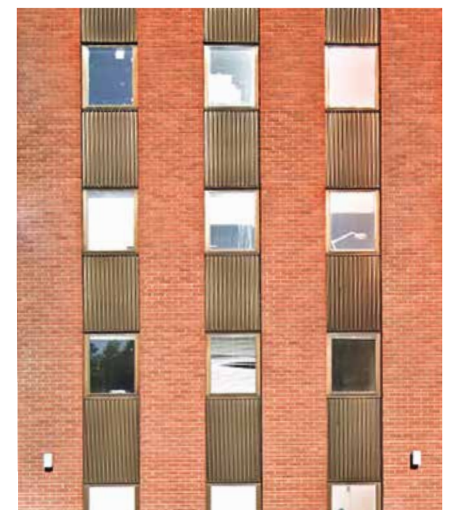
Tegelfasad från 70-talet samt vertikal fönstersättning i utfackningsväggar mellan tegelpartier
