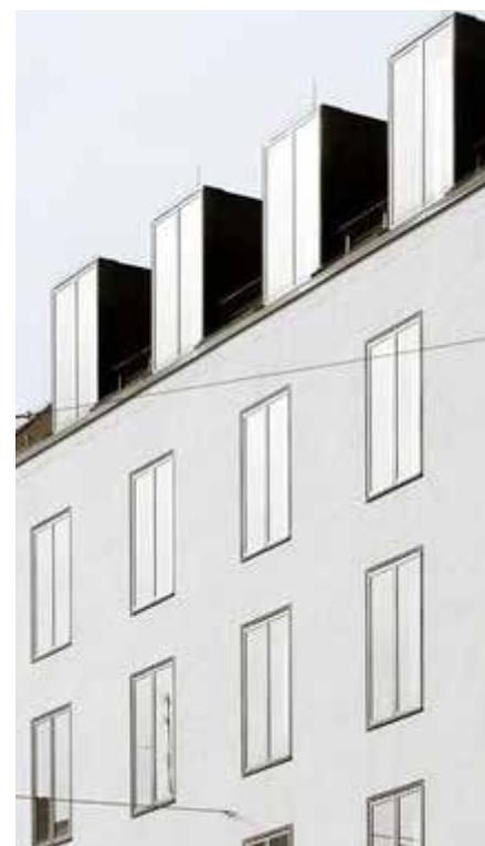
Exempel på fönster med nätta dimensioner på karm och båg. Takkupor och plåtdetaljer i samma kulör som tak (Ref: Auer Weber. Foto: Auer Weber)
